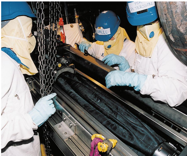
Exempel på bidrag till bättre arbetsmiljö är samarbetet med ABB vad gäller framtagning av flödesstoppren, en "gummiblåsa" som har en viktig roll vid renovering av kärnkraftverk.
