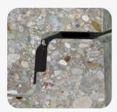
Die Dichtung muss gleichmäßig auf der gesamten Schulter aufliegen. Auf ein zentrisches aufsetzen der Aufbauteile ist unbedingt zu achten.
