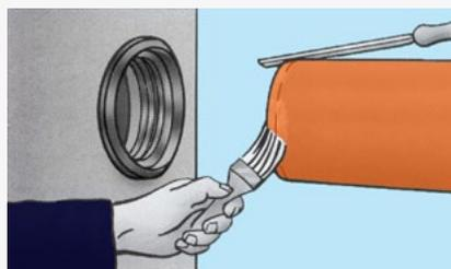
Auf das Spitzende des Anschlussrohres Trelleborg 992 Gleitmittel auftragen. Das Rohrende ist entsprechend an zu fassen.
