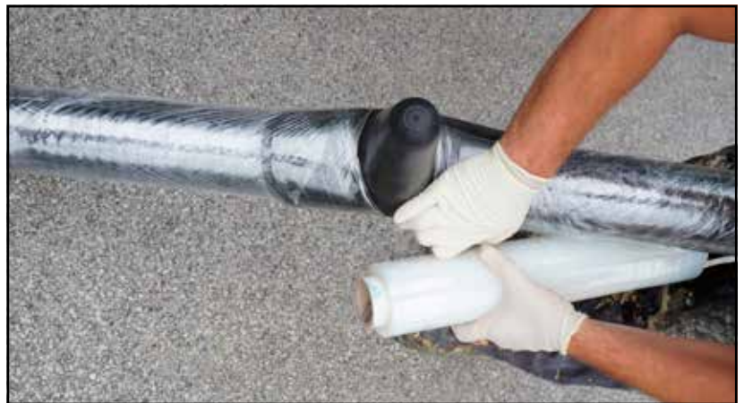
Abbildung 14: Den Hut auf den Sava-Packer mittels Schutzfolie befestigen
