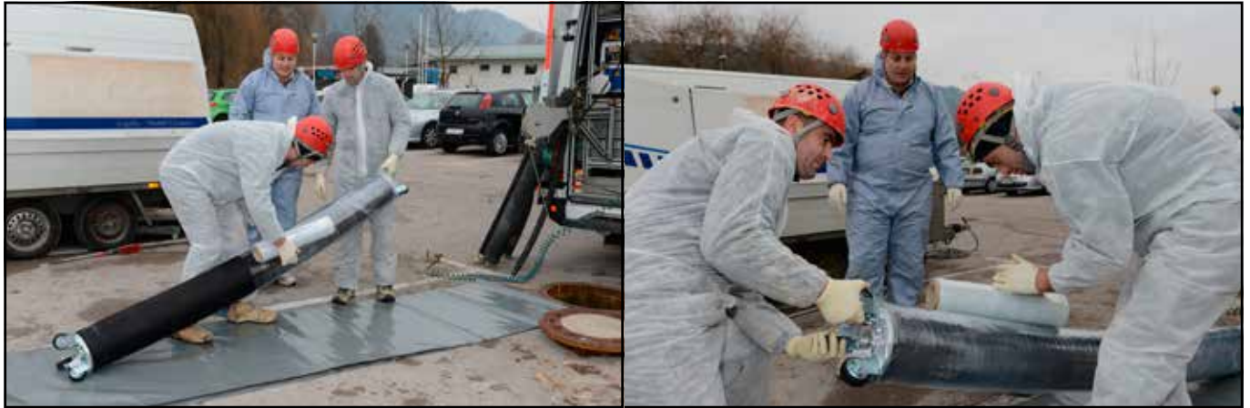
Abbildung 8: Die Schutzfolie auftragen
