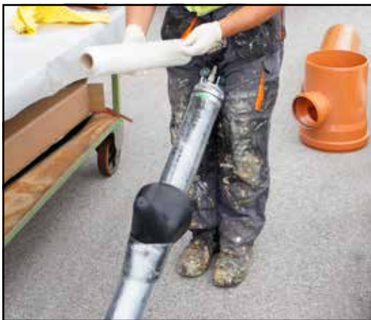
Abbildung 14: Den Hut auf den Sava-Packer mittels Schutzfolie befestigen
