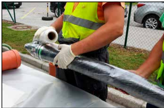
Abbildung 11: Die Schutzfolie auf den SAVA.-Packer anbringen
