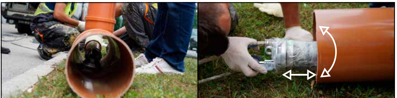
Abbildung 20: Den SAVA T-Packer ins Rohr einsetzen und positionieren
