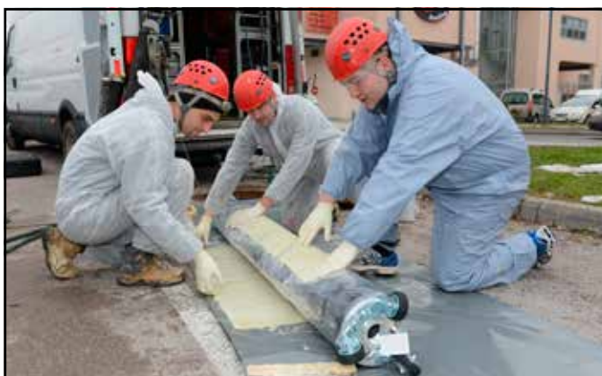
Abbildung 9: Harzgetränkte Fasern auf den geschützten SAVA-Packer auftragen
