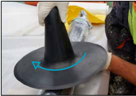
Abbildung 12: Den Hut auf den SAVA-Packer aufschrauben
