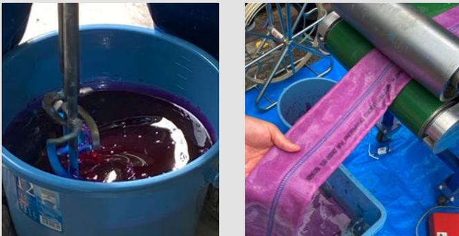
Um die Aushärtung in der begrenzten Zeit, die für die Sanierung zur Verfügung stand, zu beschleunigen, entschied sich das Team für Trelleborg Epoxy FC30 Harz. Mit einer Topfzeit von 30 Minuten und einer Aushärtezeit von einer Stunde war Trelleborg Epoxy FC30 die optimale Lösung für dieses Projekt.
