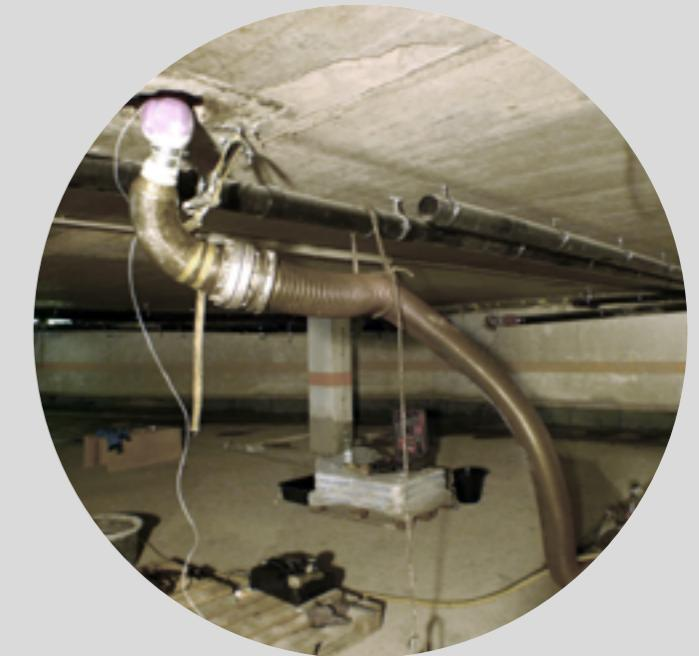
und weiter über zwei 90 Grad Bögen über eine Gesamtlänge von 13 Metern und davon 7,5 Meter senkrecht hochführt. Erst die Kamera-Aufnahmen ermöglichen eine sorgfältige Untersuchung der defekten Stelle. Zur Sicherheit führte das Team unmittelbar nach dieser Kamerauntersuchung zusätzlich noch eine Kanaldruckprüfung durch.
