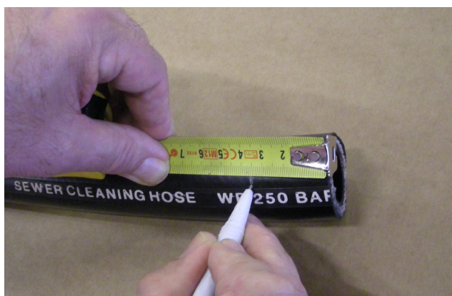
Gör en markering som anger längd L (se tabell) Make a mark indicating the length L.(Refere to table)
