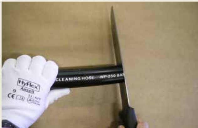
Couper le tuyau parfaitement droit. Cut the hose perfectly straight.
