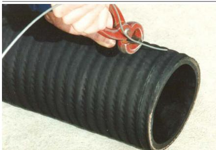
Après avoir mesuré la longueur du tuyau et couper celui-ci, dégager la spire métallique sur l'extérieur du tuyau.
