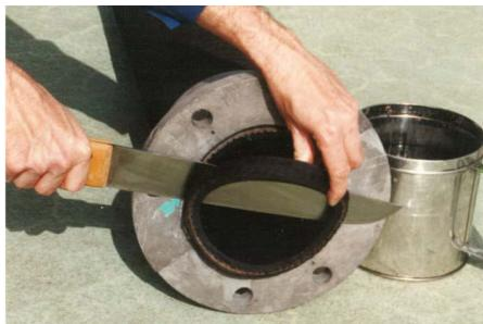
Couper l'extrémité du tuyau à l'aide d'un couteau (ou d'une scie à main) en prenant appui contre la face de la bride (flèche verte). Pour faciliter la coupe, commencer dans le creux de l'onde du tuyau et humidifier la lame. La coupe doit être alignée avec la face de la bride sans partie en saillie ou en retrait de plus de 1 mm.
