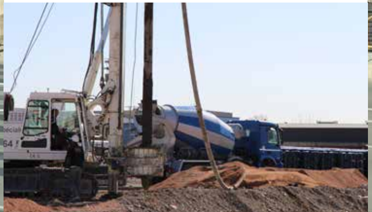
Kontinuerlig borming och fyllning av betongpelare
