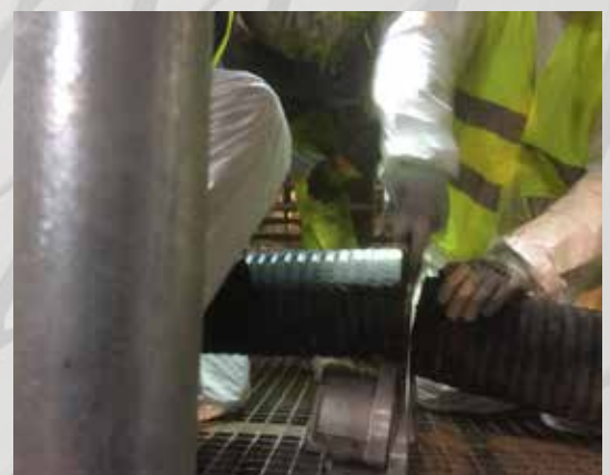
Découpe du tuyau sur site avec un simple couteau
