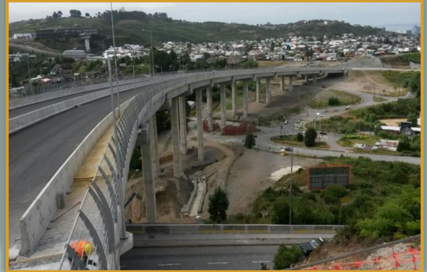
Viaducto Chamizas Puerto Montt (Chile)
