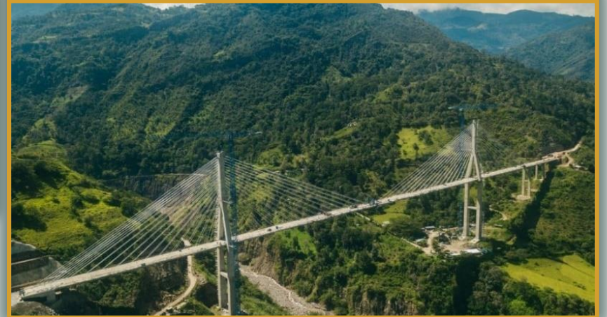
Puente Hisgaura Malaga-Los Curos (Colombia)
