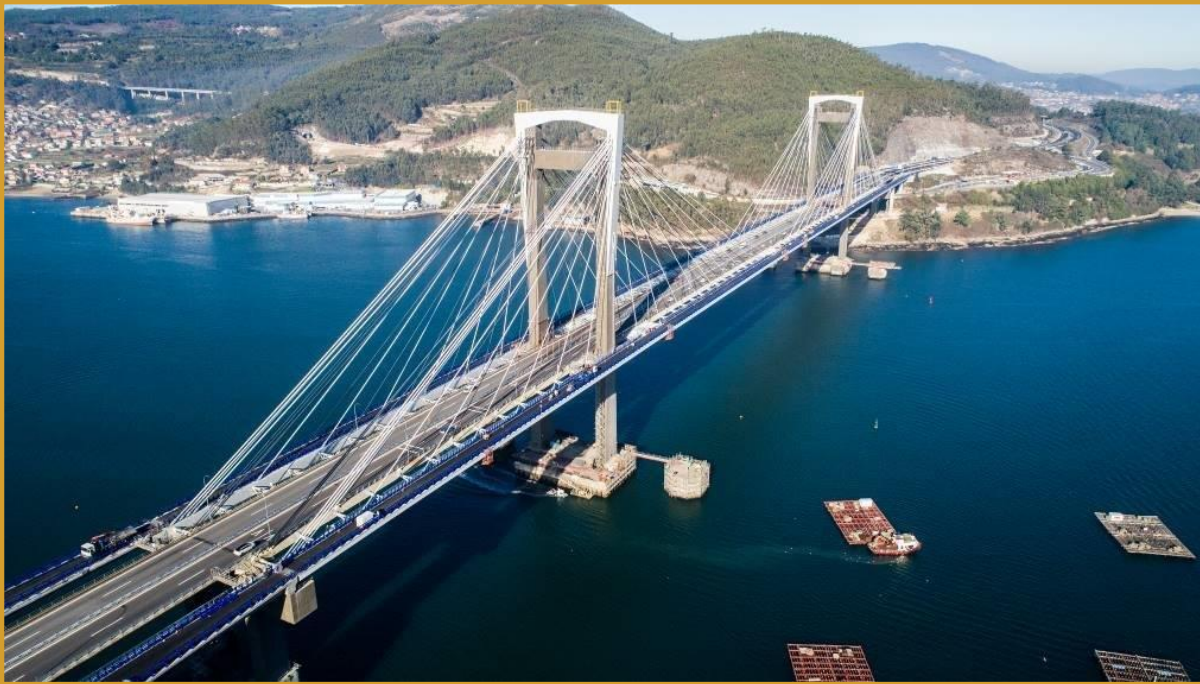
Accesos Puente de Rande Pontevedra (Spain)
