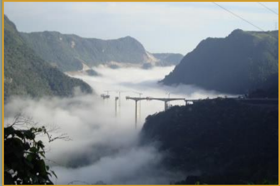
San Marcos Viaduct Itzatlán (Mexico)
