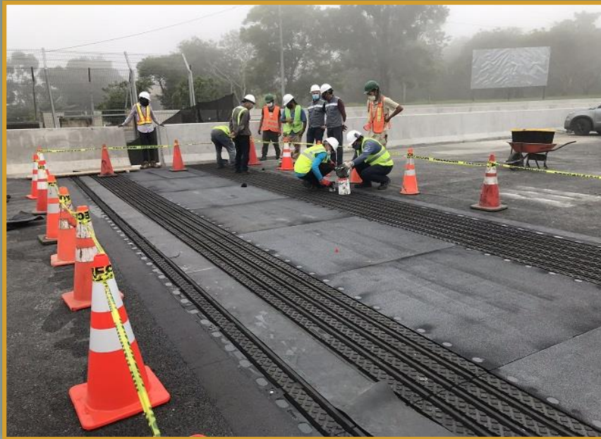
Puente Virilla (Costa Rica)
