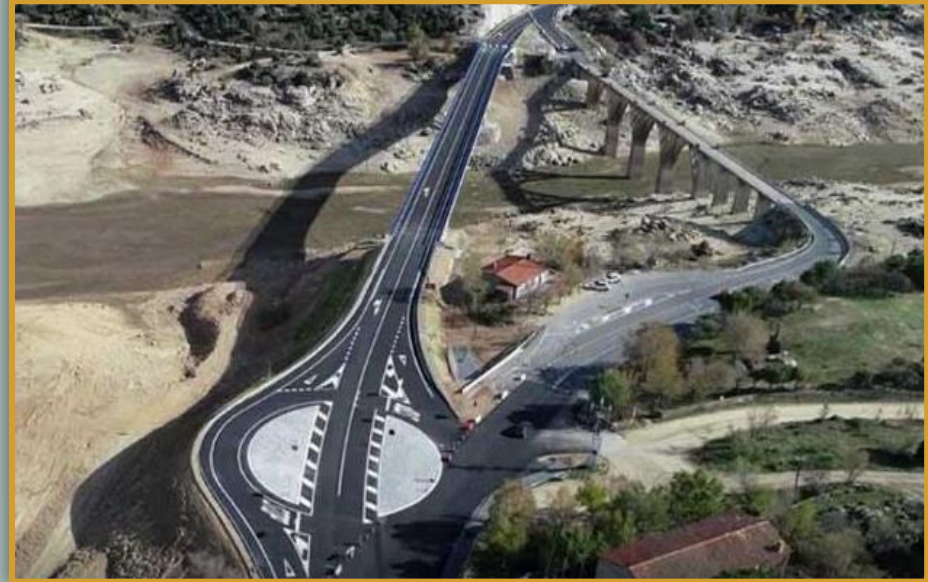
Puente la Gaznata (Avila-Spain)
