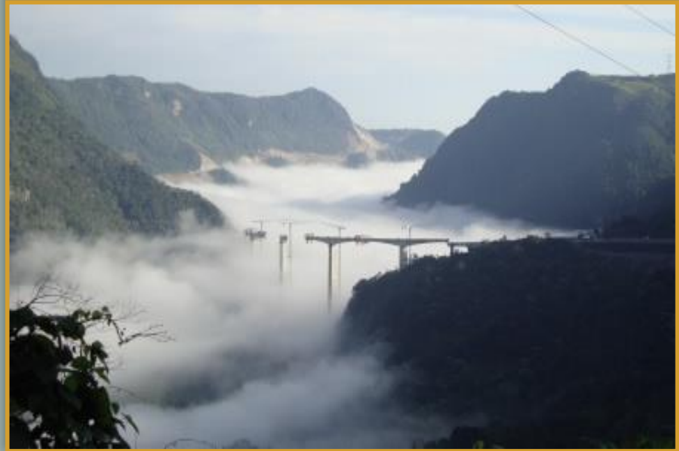
San Marcos Viaduct Itzatlán (Mexico)
