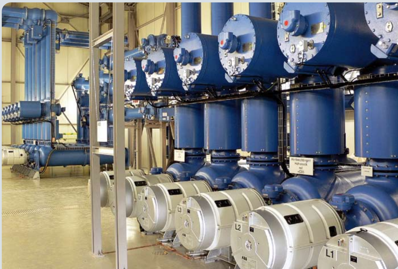
Gasolierte Schaltanlage Typ ELK3 mit hydromechanischem Federspeicherantrieb HMB-8
