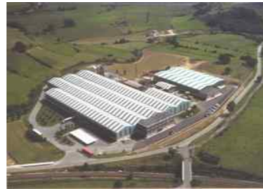
Nuestras instalaciones en Izarra donde se fabrica la junta TRANSFLEX®
