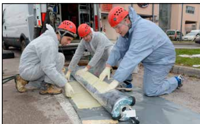
Slika 9: Nanos vlaken s smolo na zaščiten paker SAVA.
