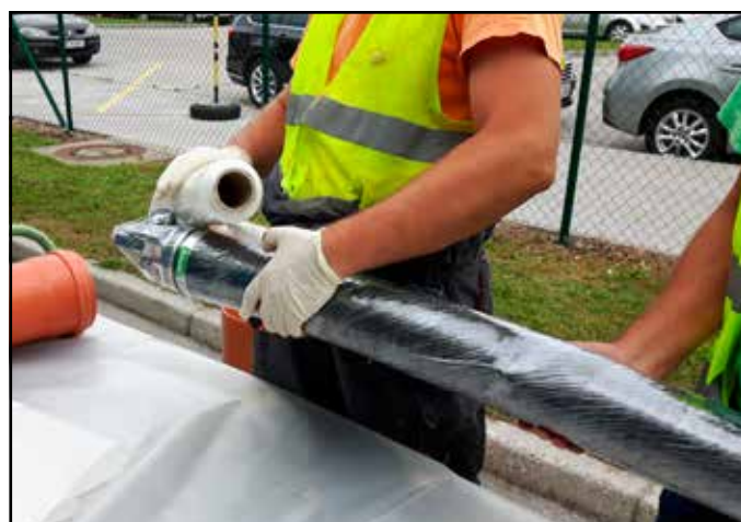
Slika 11: Nameščanje zaščitne folije na paker SAVA
