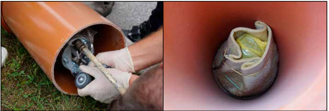
Slika 21: Pozicioniranje T pakerja SAVA v cev.
