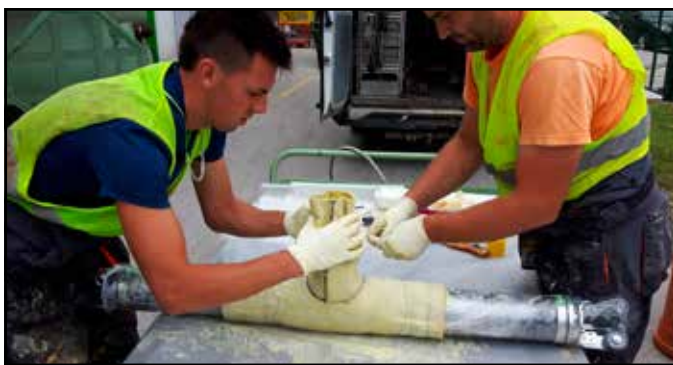
Slika 18: Nanos vlaken s smolo na zaščiten T paker SAVA in pritrditev le teh z elastikami.
