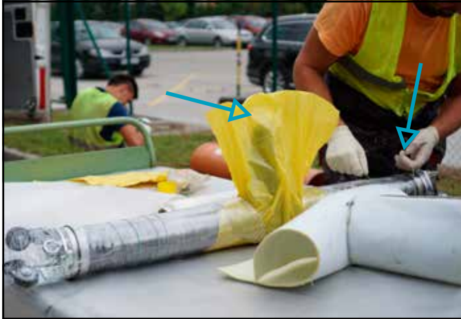
Slika 16: Nameščanje PVC zaščite na klobuk.
