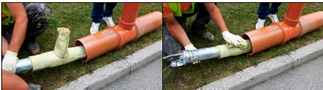
Slika 19: Vstavitev T pakerja SAVA v cev.
