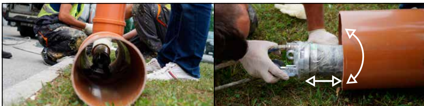
Slika 20: Vstavitev T pakerja SAVA v cev in pozicioniranje.
