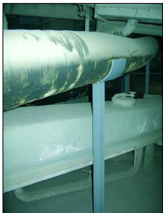
Figure 3 – Le supportage des tuyaux (patins, poutres) est généralement assuré par le client final
