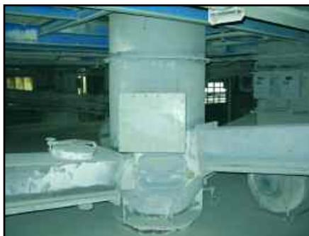
Figure 1 – La principale difficulté tenait à la présence d'une véritable forêt d'aéroglissières sous les différents silos, ce qui rendait la modification délicate
