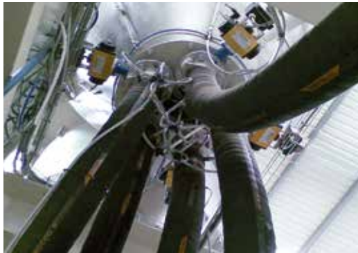
Förderung von Quarzsand Beschickung von 5 Produktionssträngen von nur einem Silo aus.
